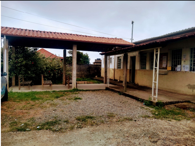
Cobertura que deverá ser retirada e realocada conforme projeto
