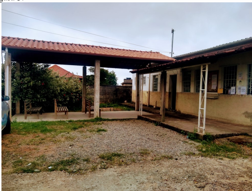
Figura 3 - Cobertura que deverá ser trocada de lugar Fonte: Cristiane Dornelas Saviotti
